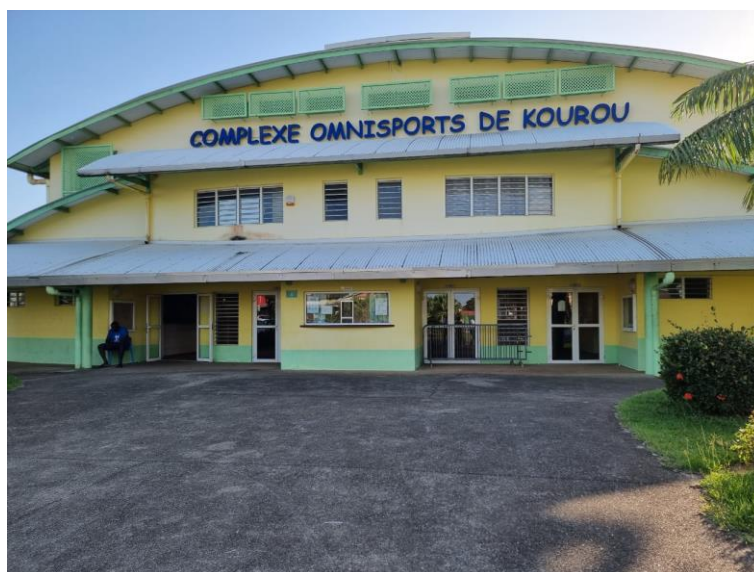
Complexe omnisports de Kourou, Guyane
